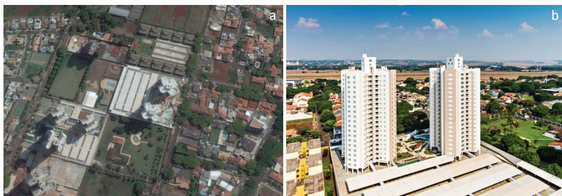
Figuras 4.13a e 4.13b: Imóvel notificado na 1ª etapa (ZR3), com projeto aprovado e obra em construção
