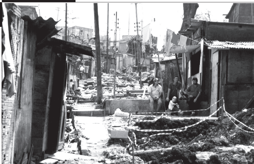
Favela Tamarutaca (núcleo consolidável) – Santo André. Remoção de famílias para abertura de viário.
