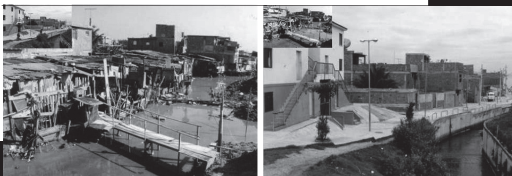
Figuras 61 e 62: Antes e depois Parque Royal - Favela urbanizada; implantação de ciclovia e vias de acesso. Fonte: PMRJ Prefeitura Municipal do Rio de Janeiro.
