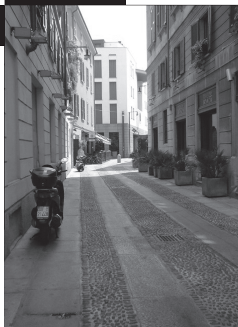
Figura 13: Via com drenagem central Fonte: Arquivo dos autores.
