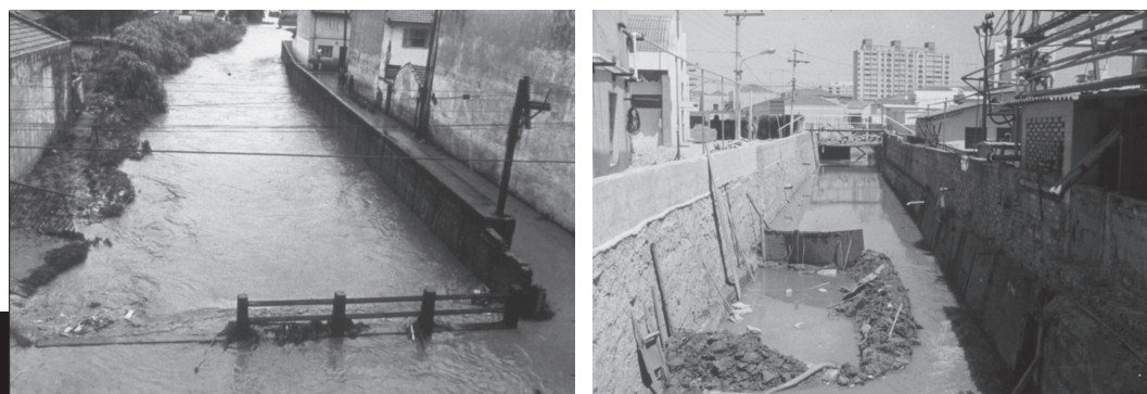
Figuras 10 e 11: Urbanização em fundos de vale com risco de enchentes, típica dos aglomerados metropolitanos. Fonte: Arquivo dos autores.
