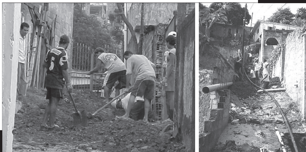
Figuras 35 e 36: Implantação da rede de abastecimento SAAE e comunidade em parceria no Núcleo Jardim Santa Quitéria e obras de saneamento no Núcleo Santa Angelina. Fonte: Serviço Autônomo de Água e Esgoto (SAAE) de Guarulhos.
