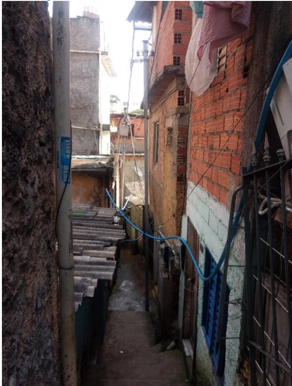
**Figura 47 – Sapé: paredes inacabadas, vãos de iluminação e ventilação insuficientes e escada fora de padrão**
