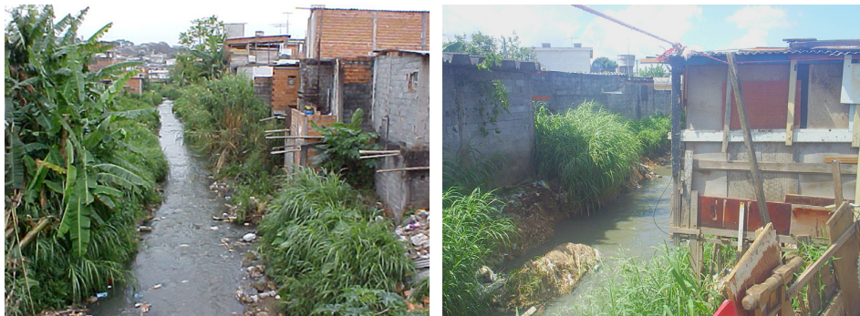
Figura 1. Ocupação nas margens do córrego Itaim antes da construção do parque
