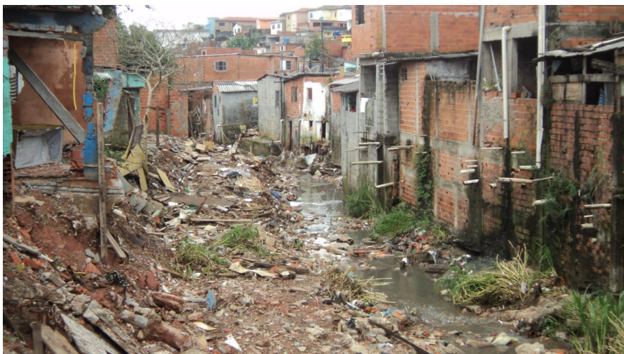
Figura 2: Ocupação precária das margens do córrego em 2008. Fonte: Defesa Civil / PMSP (2008).
