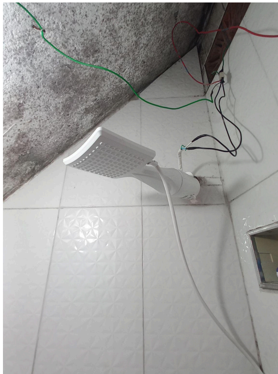
Figuras 17 e 18: Exemplos de unidades com umidade e infiltração e instalações elétricas precárias.
