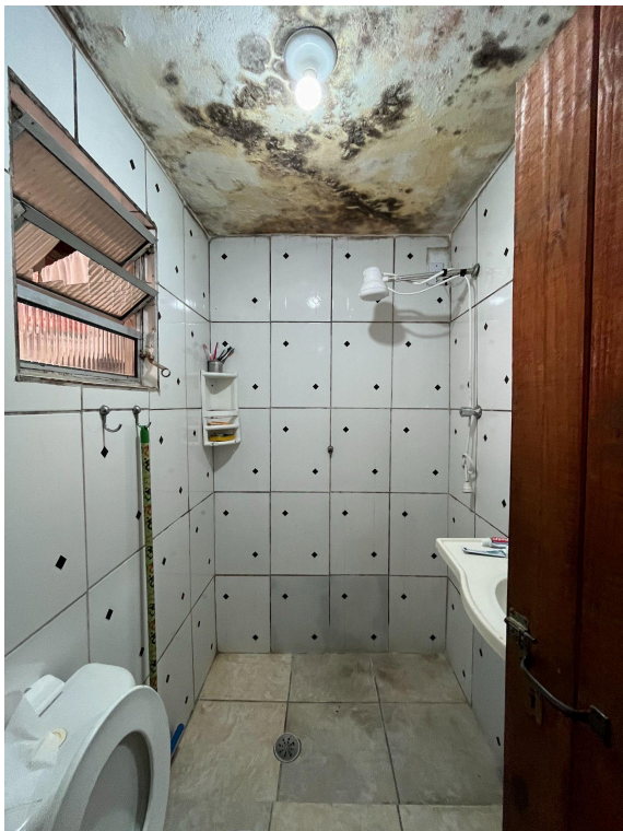
Figuras 17 e 18: Exemplos de unidades com umidade e infiltração e instalações elétricas precárias.
