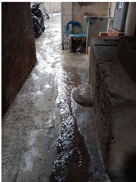
Figuras 11 e 12: Ocorrência de problemas de drenagem superficial em vias que dão acesso às edificações.
