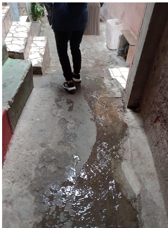
Figuras 11 e 12: Ocorrência de problemas de drenagem superficial em vias que dão acesso às edificações.
